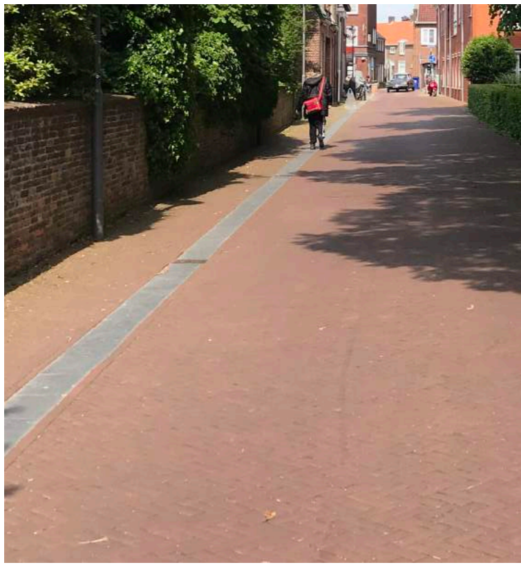
rode klinker met smalle loopzone twee verschillende bestratingsverbanden een goot van beton: verwijzing naar inrichting Hokenkwartier
