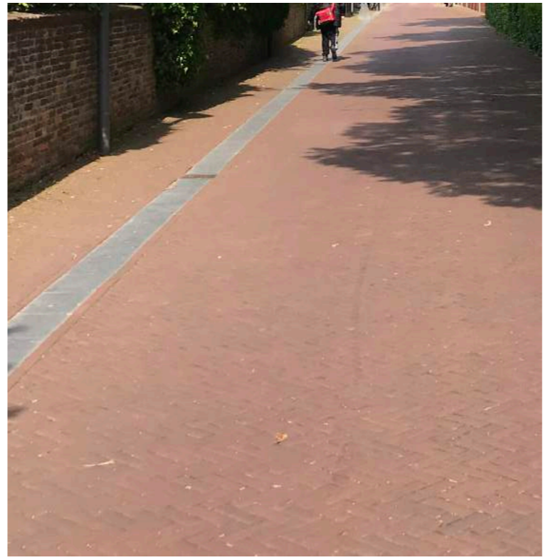
verlaagde band als markering en afwatering
