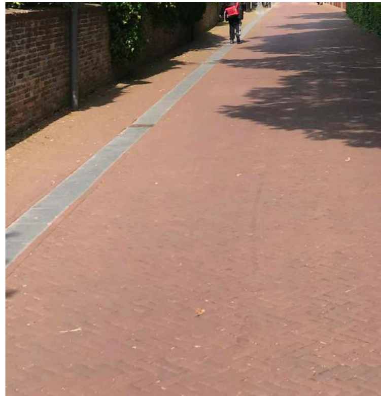
verlaagde band als markering en afwatering
