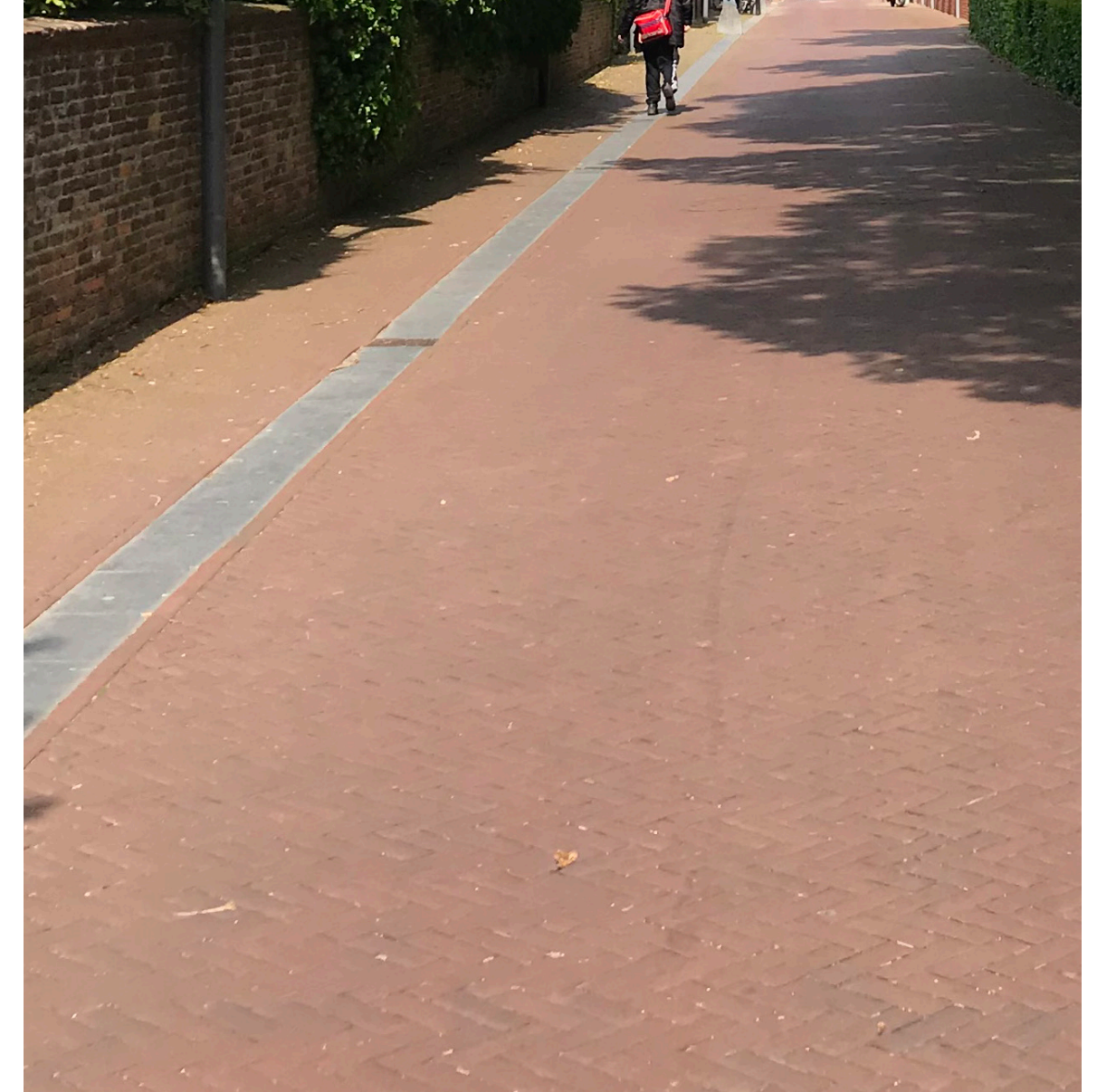
verlaagde band als markering en afwatering
